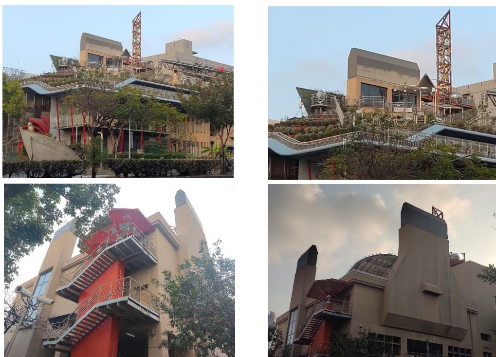
圖 1-4-1-1 綠色魔法學校捕風塔設置(自行拍攝)
