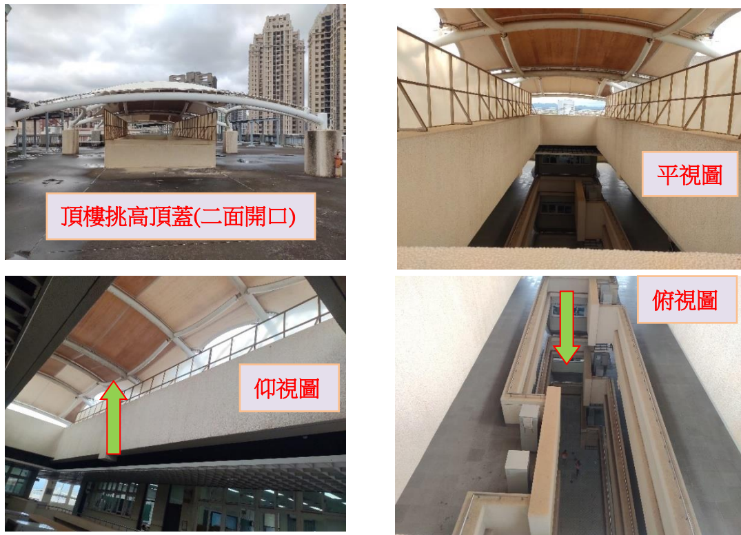
圖 1-4-2-1 教學大樓中庭挑空，頂蓋挑高設計、二面開口，增加採光通風 (自行拍攝)
