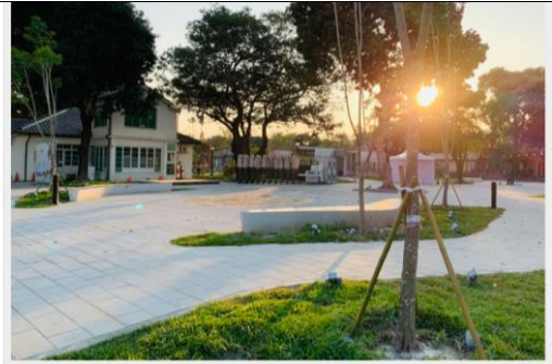
「漫步阿猴城-眷村周邊綠網串連計畫」施工後串聯周邊，具改善民眾休閒、觀光動線之效益，帶動屏東的地區發展。(內政部營建署提供)
