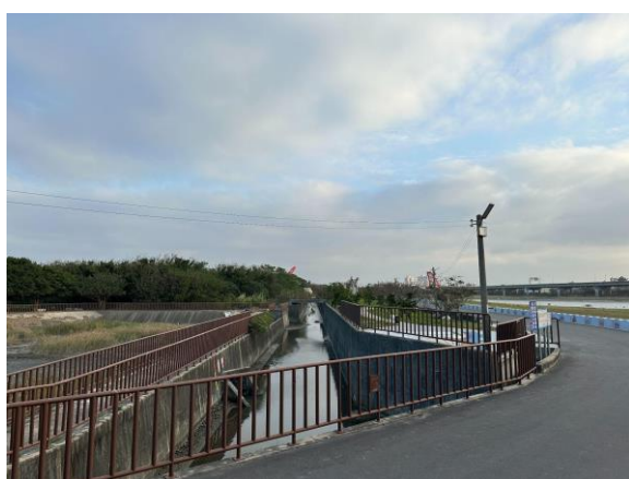
↑ 舊港島下游處的排水溝一景。
