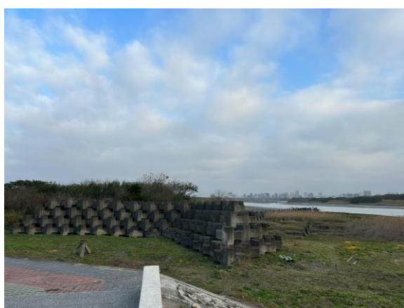
↑ 舊港島上游處的堤防及消波塊。
